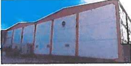
Katlı Hatların yer aldığı Konverting-2 Fabrikası
