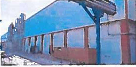
TM 1 ve TM 2 Binası
