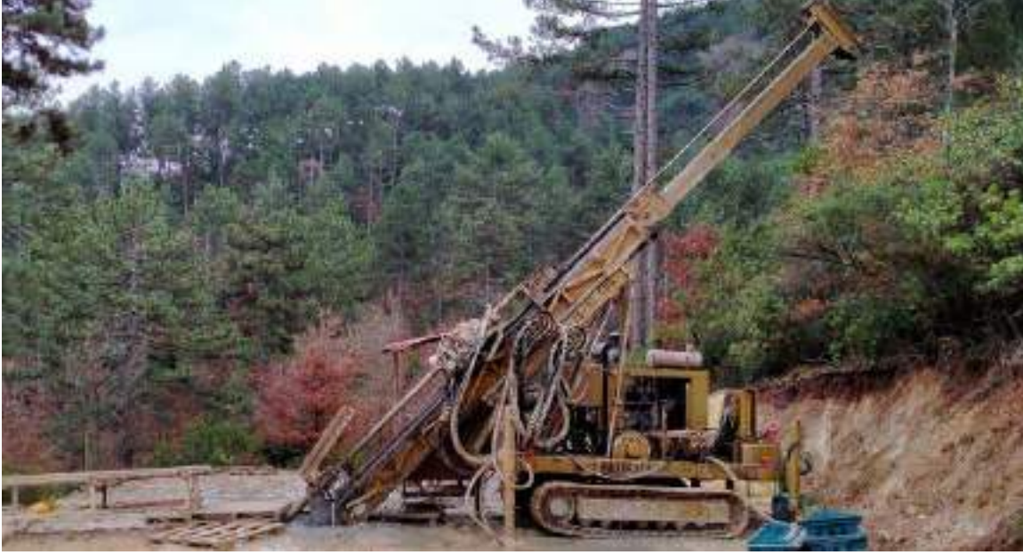
Foto 11: Doma Sahası Sondaj Çalışması
