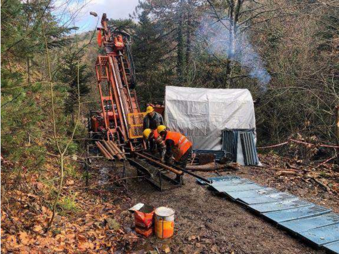
Foto 12: Spiral Ocak Bölgesi Sondaj Çalışması
