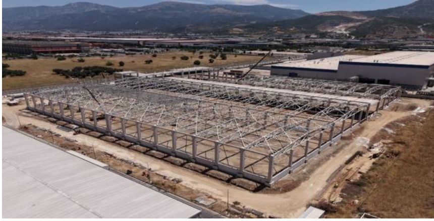
İnşası Devam Eden Manisa Ambalaj Tesisi 2 Binası
