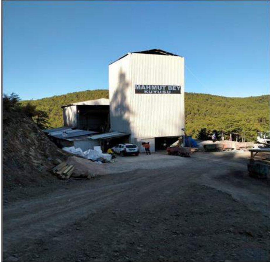
Foto 4: Mahmut Bey Kuyusu Yeraltı İşletmesi Girişi
