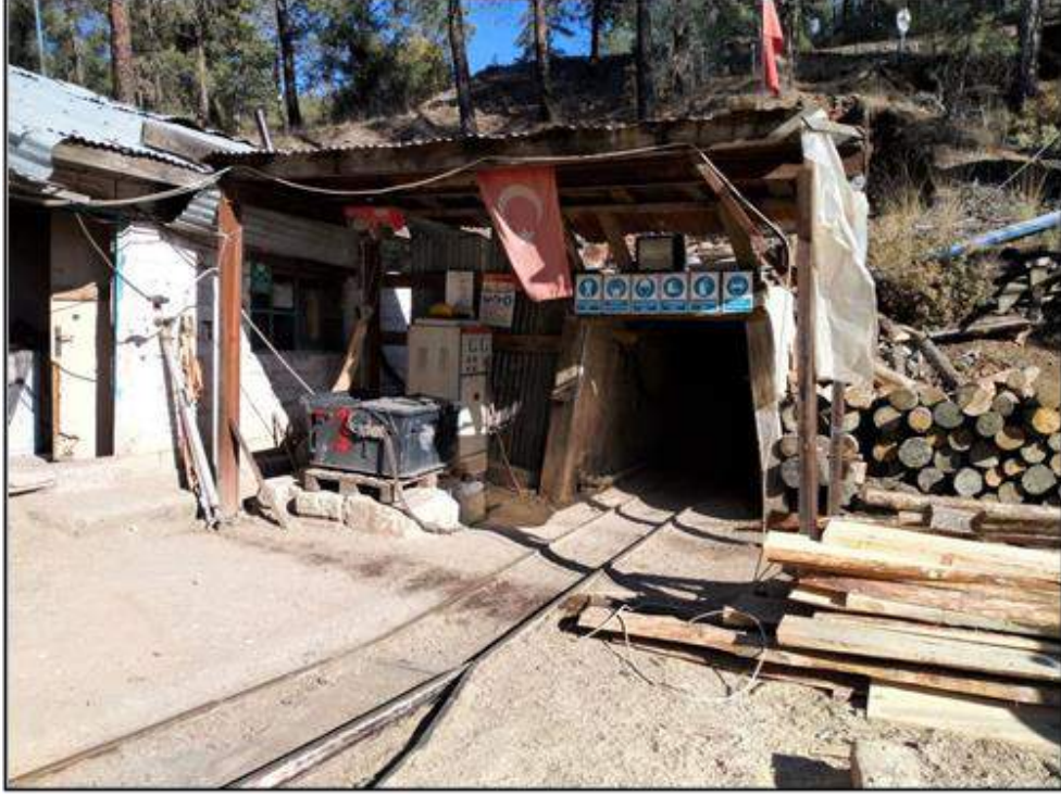
Foto 3: Hudut-3 Yeraltı İşletmesi Girişi
