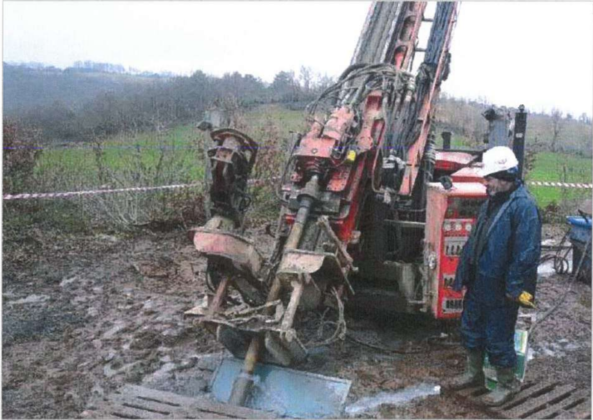
Şekil- 55. Sarıalan Altın, Gümüş Proje Alanında Yapılan Sondaj Çalışmaları
